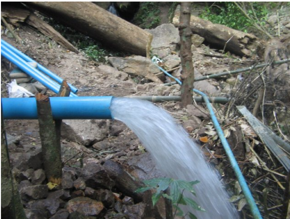
รูปที่ 12: การสื่อสารที่ผิดพลาด และการต่อท่อที่ไม่แข็งแรง เกือบทำให้เกิดความเสียหายของท่อใน powerhouse อุปกรณ์อิเล็กทรอนิกส์ทุกชิ้นเปียก แต่ไม่เกิดความเสียหายใด ๆ
